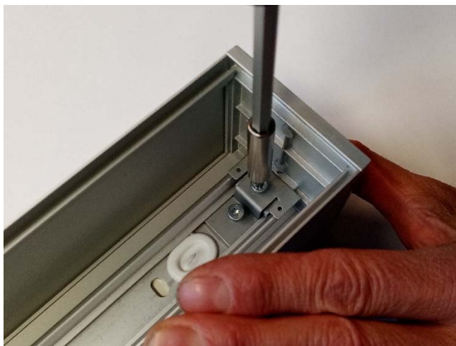
DE: Zweite Schraube bis Ende eindrehen EN: Screw in the second screw to the end FR: Visser la deuxième vis à l'extrémité
