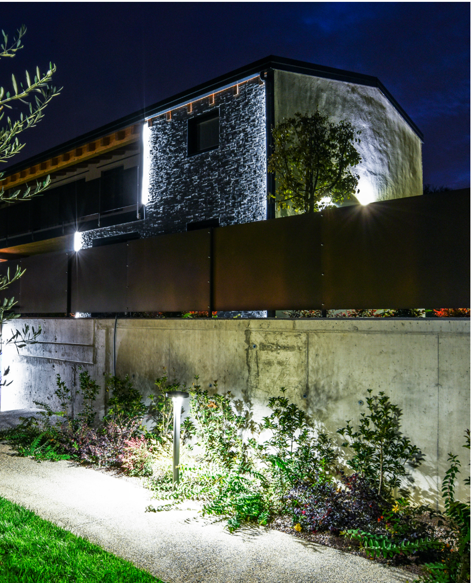
Residence "La Valle" | Barco di Lavagno | Italy
